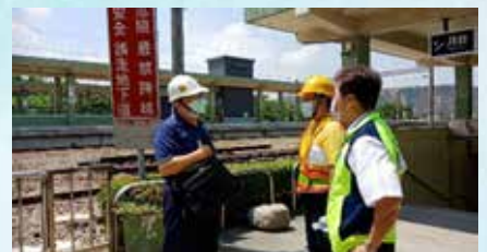
臺中分會陪同中區職安署 在日南站工程複檢
